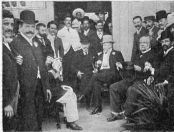
EN LA ESTACIÓN DE RIO SANTIAGO MOMENTOS ANTES DE EMPEZAR LAS MANIOBRAS
