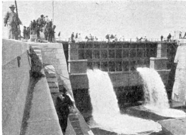
LOS PRIMEROS CHORROS DE AGUA QUE ENTRARON EN EL DIQUE
